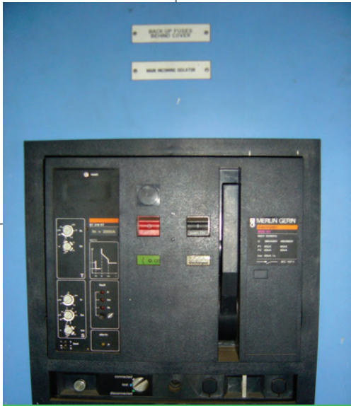
SCHNEIDER MASTERPACT
